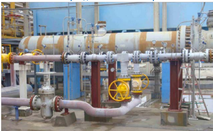
Фото 2 – Блок 3S-сепарации на УПГ месторождения YANA компании Petrochina
